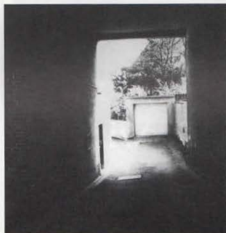
Nach Meinung der Denkmalschützer trotz positiven Brandschutz-Gutachtens umstritten: Die schmale Tordurchfahrt an der Oberwallstraße, die im Brandfall zur Durchfahrt für die Feuerwehr dienen soll.
